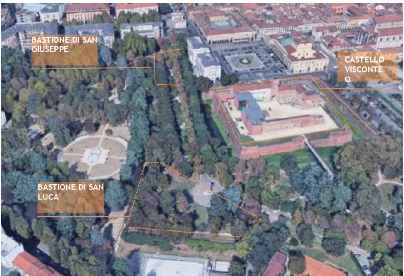
Foto elaborata per relazione "INTERVENTO DI RESTAURO E CONSERVAZIONE DELLE MURA DEL CASTELLO VISCONTEO SFORZESCO E DEI BASTIONI DI SAN LUCA E SAN GIUSEPPE A NOVARA"
